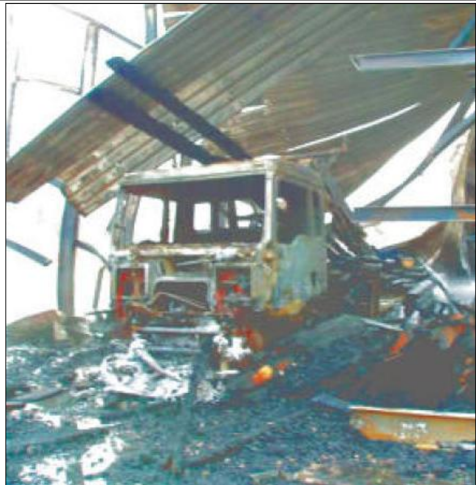
In den Trümmern des Holzlagers stand der Laster, der wegen einer defekten Elektrik zum Auslöser des Großbrands geworden war. Foto: Keller
